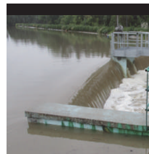
Bassin de Bures
