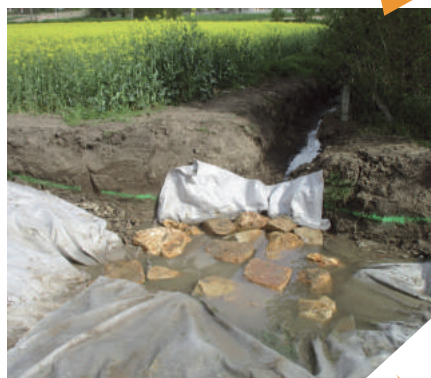
Restauration du lit
