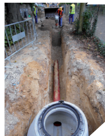
Pose canalisation assainissement + regard
