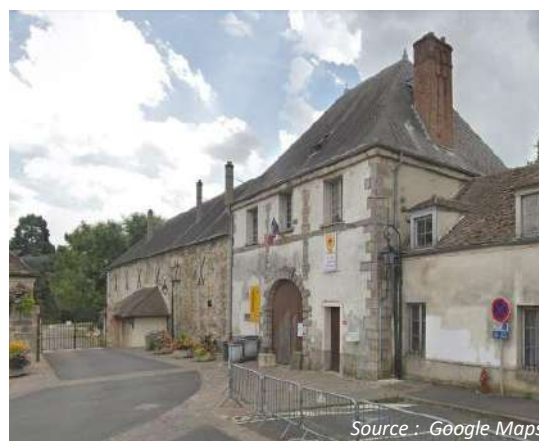
Le Château de Villebon : 7 rue du Baron de Nivière
